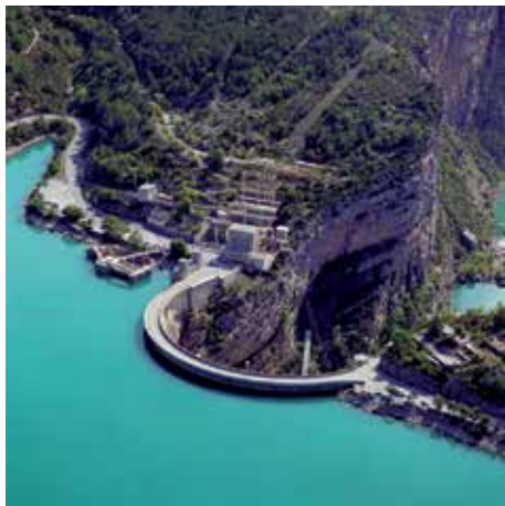
Demandolx (04), vue aérienne de la centrale hydraulique du barrage de Castillon
