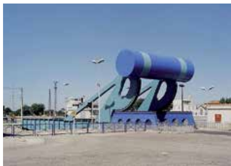
Port-Saint-Louis-du-Rhône (13), pont mobile
