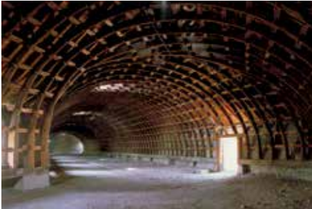
Mont-Dauphin (05), charpente de la caserne Rochambeau
