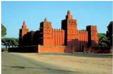
Fréjus (83), mosquée de Missiri
