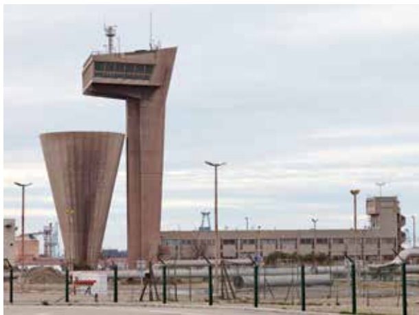
Fos-sur-Mer (13), vigie et réservoir du port
