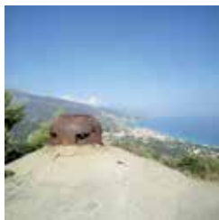
Roquebrune-Cap-Martin (06), ouvrage mixte de Roquebrune Cornillat
